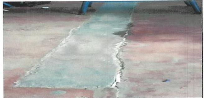
**Foto 6:** El piso de salón de clase esta deriorado, lo cual se puede evitar cambiando el actual por piso cerámico antideslizante y asi evitar cuumulación de tierra.
