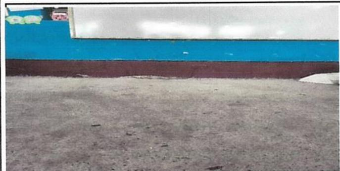
**Foto 5:** Modulo 2 actualmente el suelo del salón es de torta de cemento por lo cual es necesario colocación de piso cerámico antideslizante para evitar acumulación de polvo y tierra.
