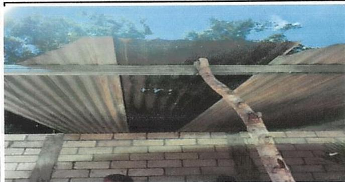
**Foto 3:** Modulo 2 Cambio de techo de galera debido a que se filtra. Y penetra el sol de forma directa, porque las láminas estan rotas.
