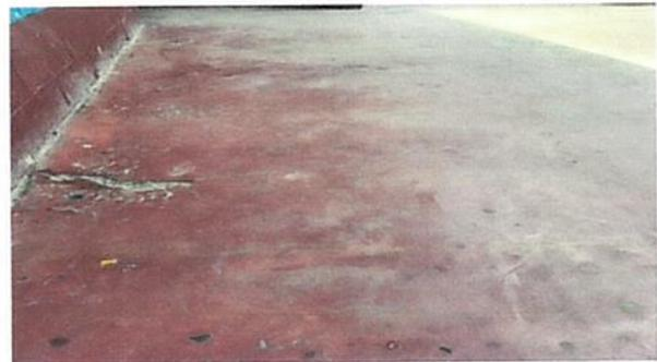
**Foto 4:** Modulo 2 actualmente el piso del corredor esta muy deteriorado por lo cual es necesario colocación de piso cerámico antideslizante para evitar acumulación de polvo y tierra.
